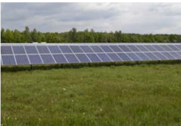
Beperk de hoogte van de panelen, zodat je er overheen kunt kijken...
