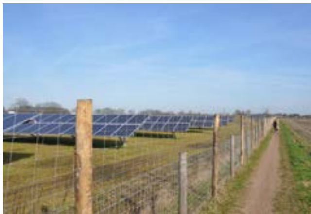
Plaats het hekwerk dicht op de panelen en houd het eenvoudig en eenduidig
