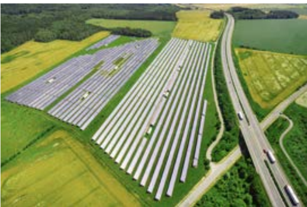
De transformatoren logisch plaatsen in het zonneveld...
